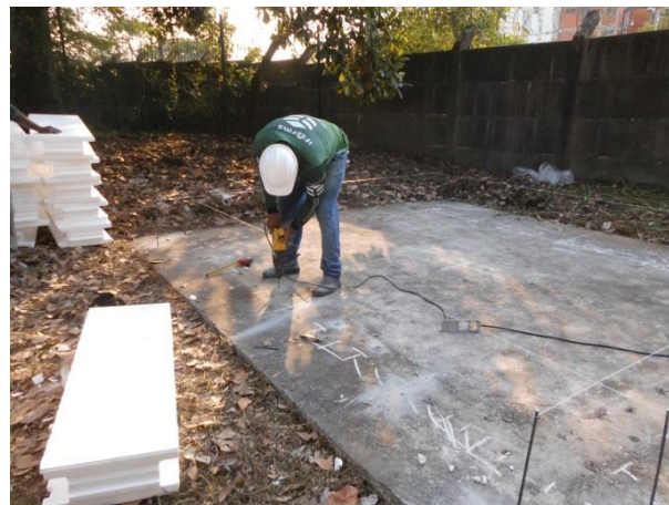
Figura 8 – Chumbamento da armadura das paredes à fundação
