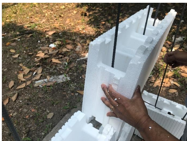
Figura 11 – Encaixe da segunda fiada
