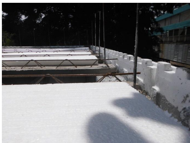
Figura 17 – Execução da laje
