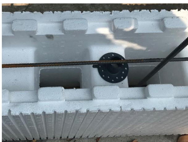
Figura 13 – Detalhe do espaçador plástico para a barra de armadura horizontal
