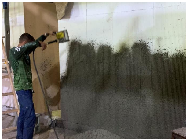
Figura 21 – Chapisco da parede
