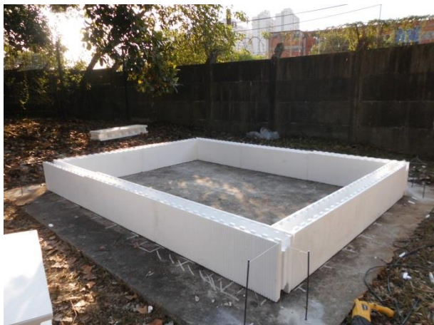
Figura 7 – Marcação da primeira fiada de blocos
