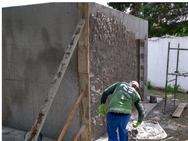
Figura 25 – Revestimento das paredes
