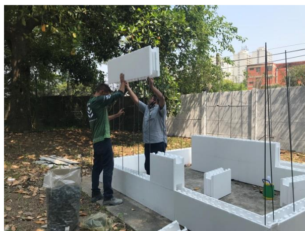
Figura 2 – Colocação dos blocos da segunda fiada
