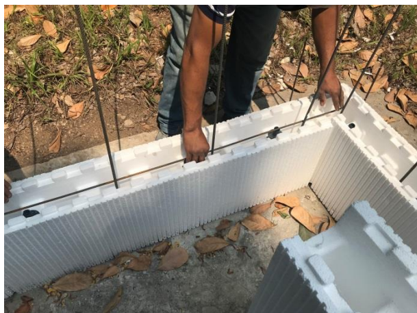
Figura 9 – Colocação das barras de armadura horizontais da primeira fiada
