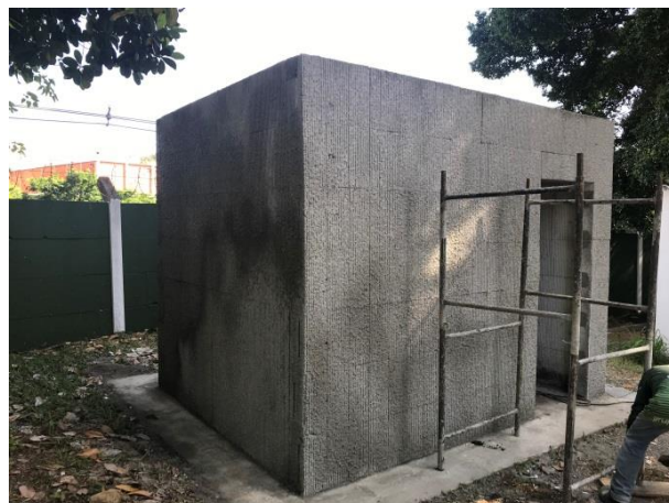
Figura 22 – Parede chapiscada
