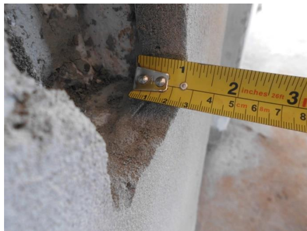
Figura 26 – Revestimento com 25 mm de espessura
