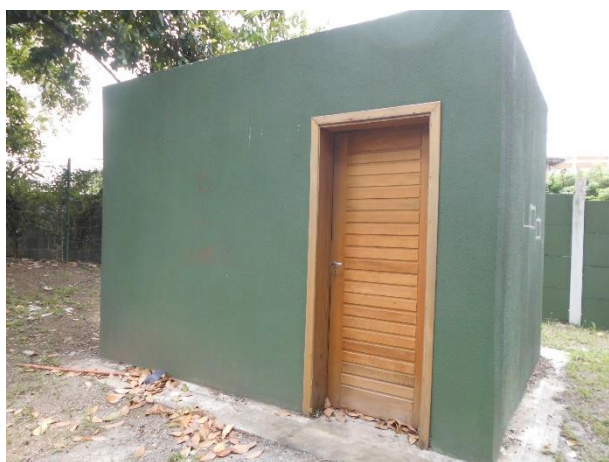
a) Parede frontal
