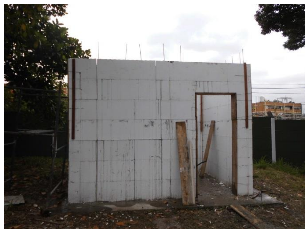
Figura 16 – Paredes com os blocos preenchidos com concreto
