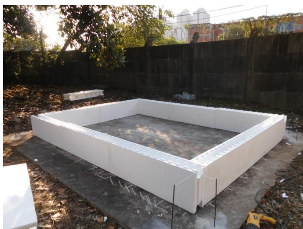
Figura 1 – Posicionamento da primeira fiada
