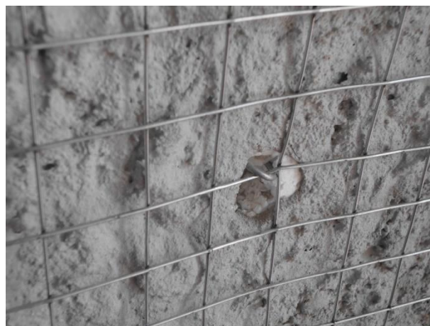
Figura 24 – Tela do revestimento
