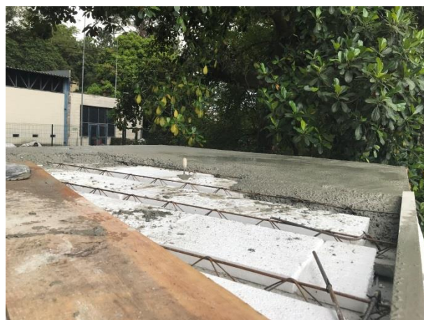
Figura 18 – Concretagem da laje
