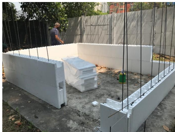
Figura 10 – Assentamento da segunda fiada
