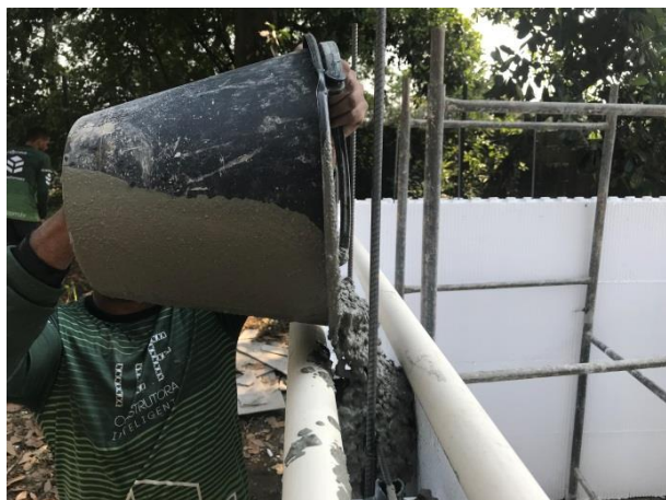
Figura 15 – Lançamento do concreto
