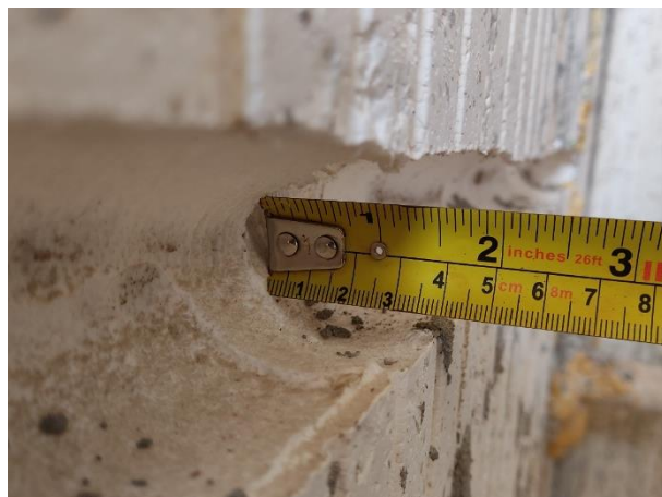
Figura 20 – Rebaixo no EPS para embutimento de tubulação
