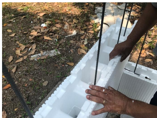
Figura 12 – Encaixe da segunda fiada
