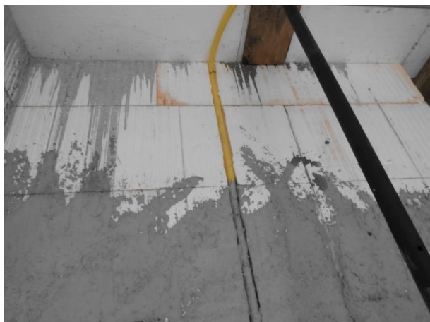
Figura 19 – Eletroduto embutido em rebaixo
