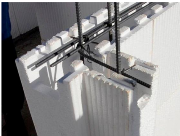
Figura 4 – Ligação entre paredes a 90 graus
